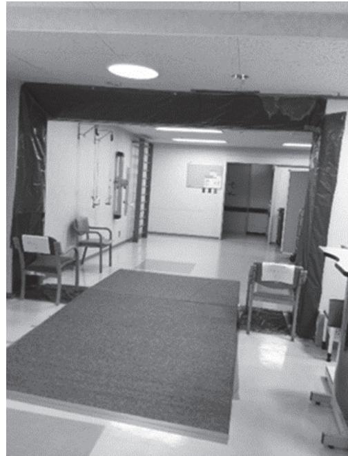
写真4 併施設間の段差にスロープ設置
