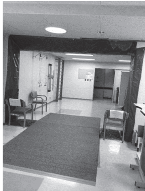
写真4 併設施設間の段差にスロープ設置
